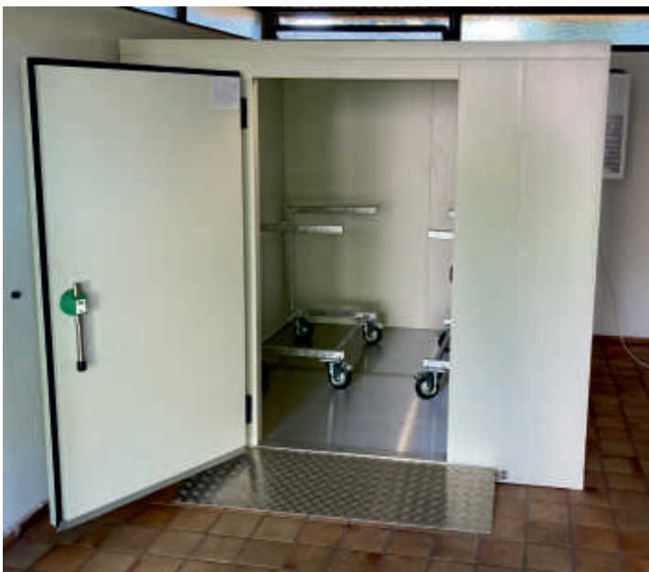
Leichenkühlzelle zur Lagerung von 4 Särgen mit fahrbaren Sargregalen
