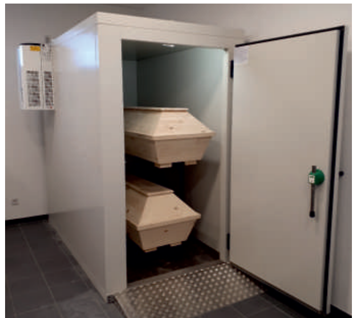
Leichenkühlzelle zur Lagerung von 2 Särgen mit Sargtransportwagen
