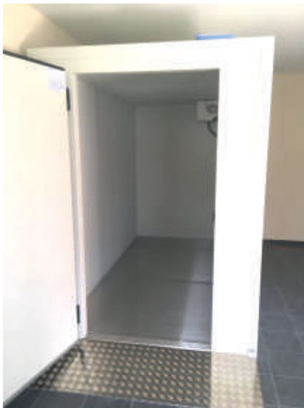
Leichenkühlzelle zur Lagerung von 2 Särgen mit Sargtransportwagen
